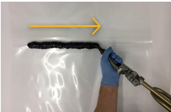
BILD 9 Klebstoffraupe in Richtung des Falzes auftragen
